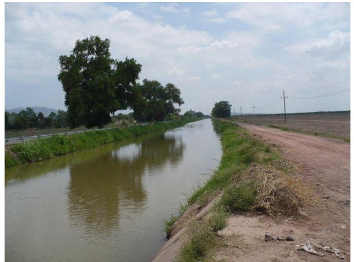
A flooded irrigation canal. N. Sinaloa
